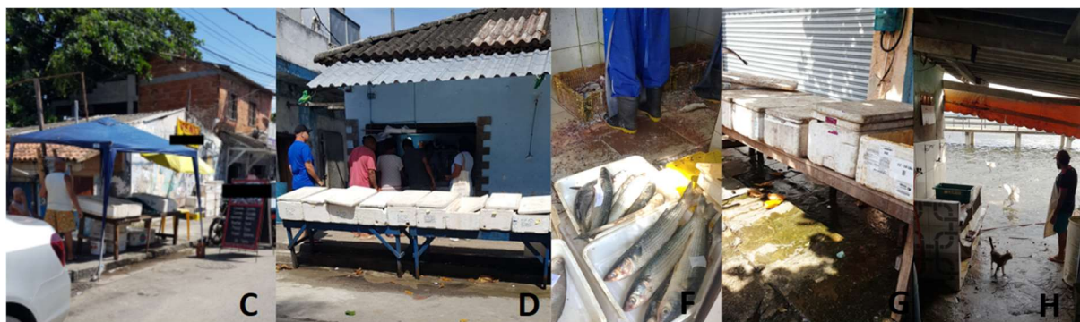
Figura 1. Não conformidades observadas nas edificações dos estabelecimentos C, D, F, G e H
